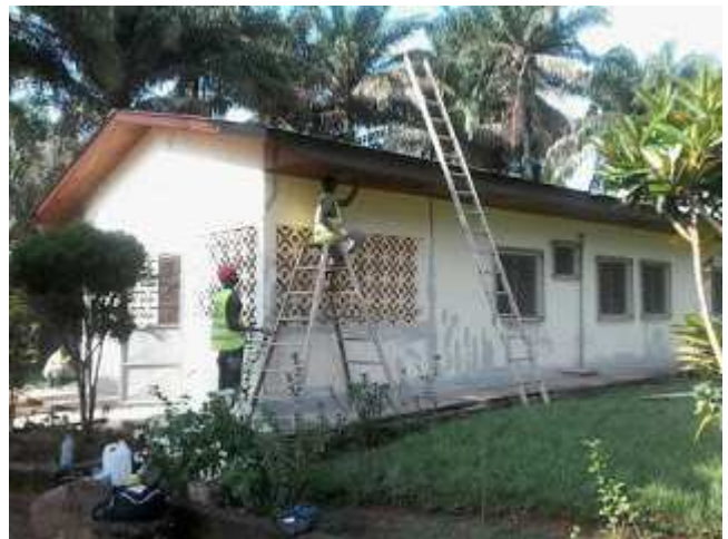
Durante i lavori
