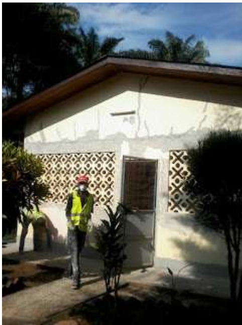
Prima della ristrutturazione
